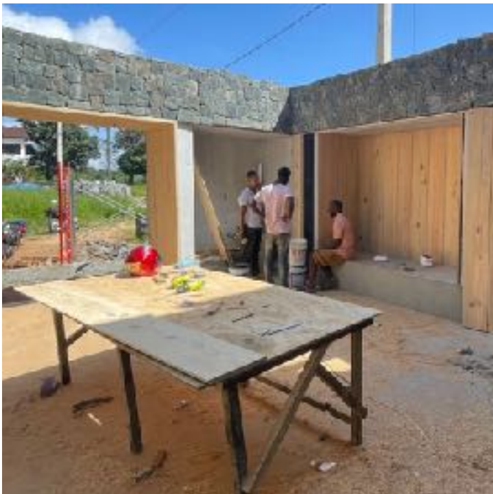
ESTAR EXTERIOR Proceso de construcción: taller de ebanistería en situ
